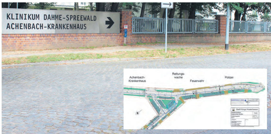
Steine des Anstoßes: Über die Köpenicker Straße erreicht man das Achenbach-Krankenhaus. In ihrem jetzigen Zustand ist das für Menschen mit Kinderwagen oder Rollatoren ein schwieriges Unterfangen. Kl. Abb: Planung für die Sanierung der Köpenicker Straße.
